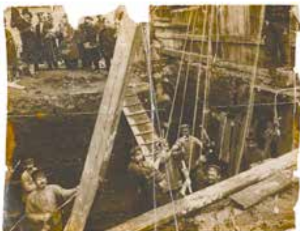
Fot. 2. AF 35990 – budowa mostu. Lico fotografii przed konserwacją (fot. Tymon Rizov-Ciechański)
